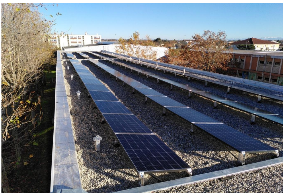
Bron école Jean Moulin : 36 kWc sur un toit terrasse bien dégagé de 500 m 2 : en terme de place il n'y a rien de trop !
