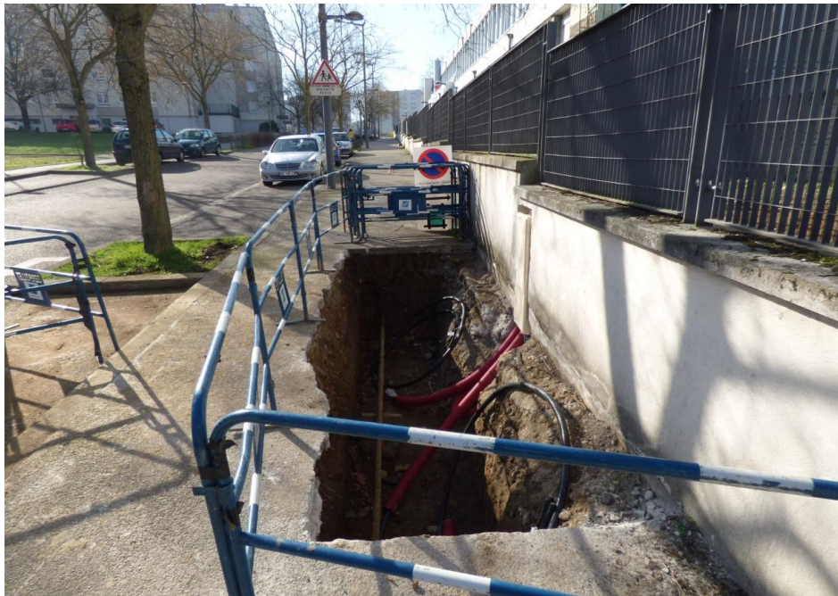
Travaux ENEDIS pour St Priest école Jules Ferry (71 kWc)
