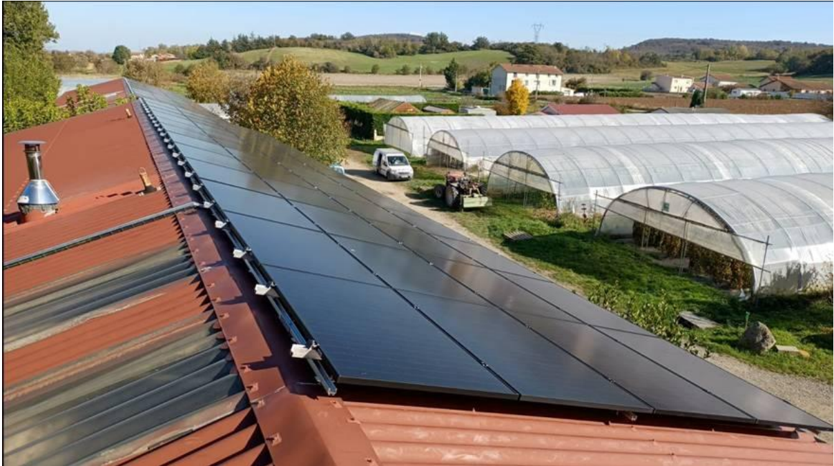
Installation de 36 kWc sur le toit des Jardins de Lucie à Communay
