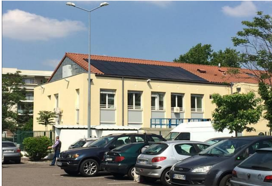
Maison de la Métropole à St Fons (9 kWc)
