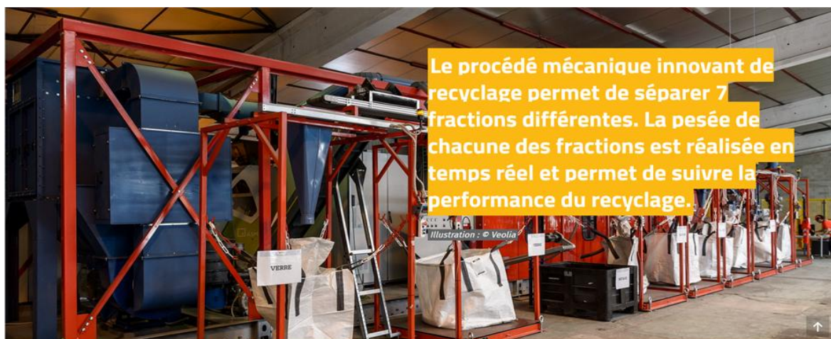
Usine de recyclage des panneaux PV à Rousset (Bouches du Rhône)
