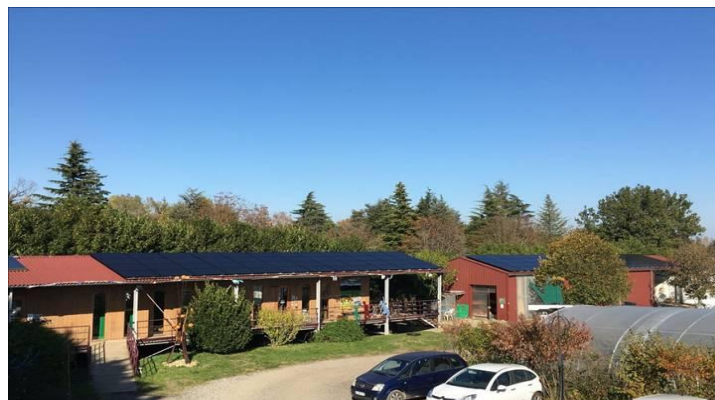
Installation de 36 kWc sur le toit des Jardins de Lucie à Communay
